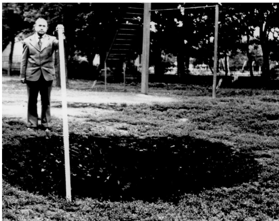
Фото 3. Обследование провала земной поверхности
